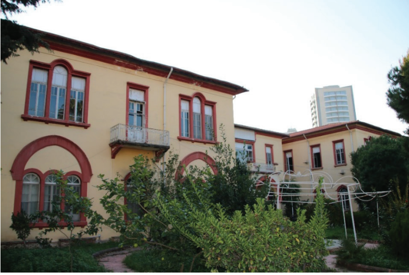
G. 12: Yapının Kuzeydoğu Cephesi (Özkan, 2021)
