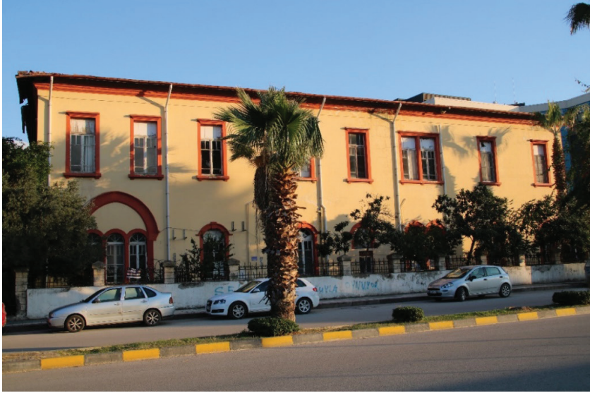
G. 13: Yapının Kuzeybatı Cephesi (Özkan, 2021)
