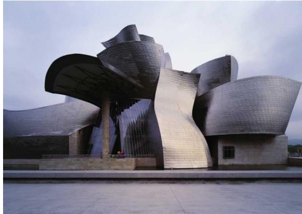
Resim 4. Guggenheim Bilbao Müzesi Giriş Görüntüsü
