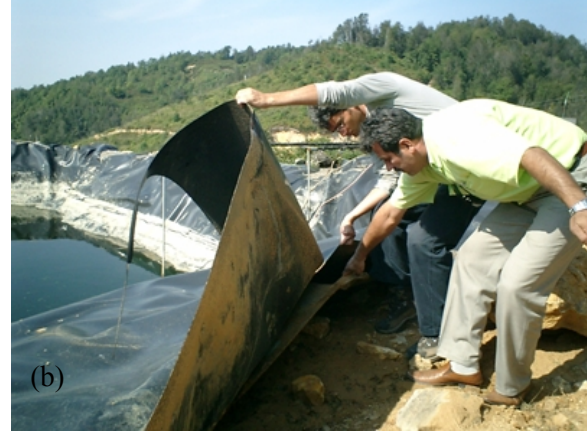
Şekil 4. (a) Depolama sahasından Ayiçi Deresi ve Kızılelma Mağarası'nın olduğu kesime bakış, (b) Jeomembrandaki yırtık ve açıklıklar.
