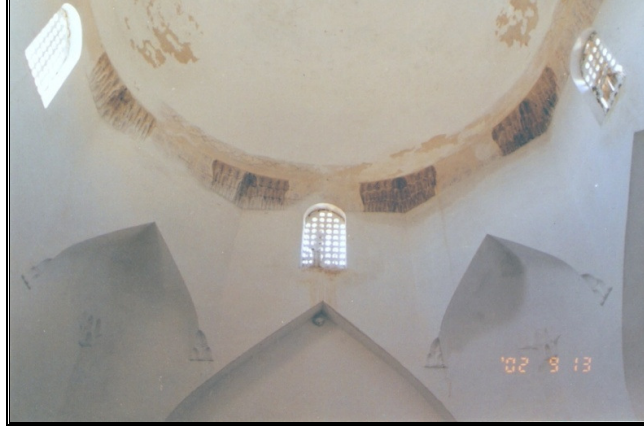
Resim 12: Suzak / Babaata, Baba Ata Türbe – Camii. Türbe mekânı, kubbeye geçiş öğeleri.
