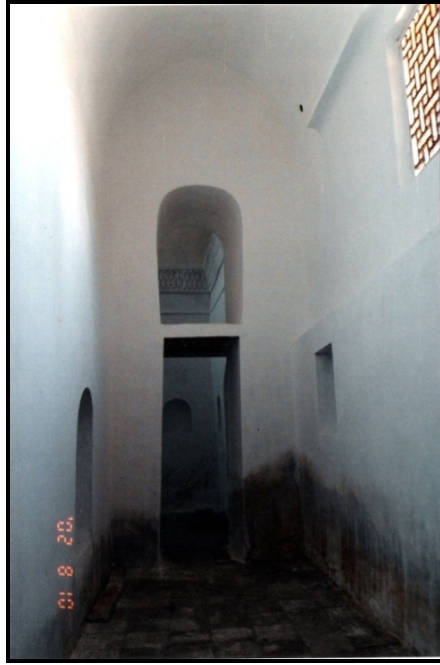
Resim 19: Kentau / Atabay, Şamet İshan Türbe – Cami. Kuzeybatı köşedeki mekânın güney duvarı.
