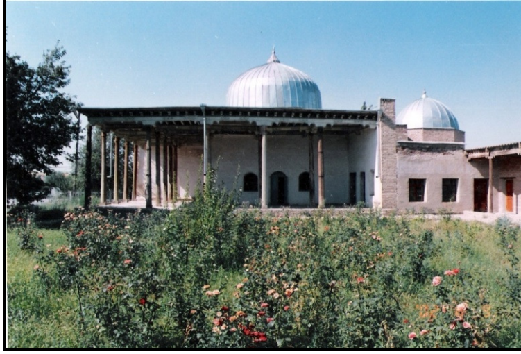
Resim 14: Kentau / Atabay, Şamet İşan Türbe – Cami. Doğu cephesi.
