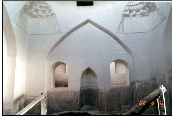
Resim 20: Kentau / Atabay, Şamet İshan Türbe – Cami. Kuzeydeki kare planlı mekânın batı duvarı.
