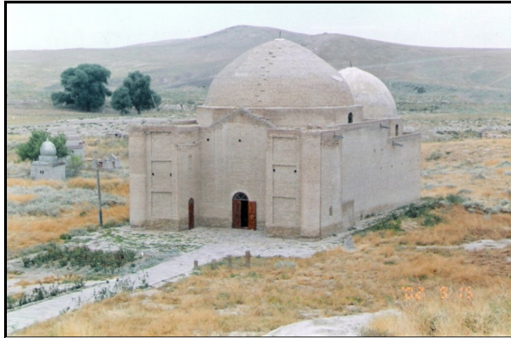
Resim 5: Suzak / Babaata, Baba Ata Türbe – Camii. Kuzeydoğu cephesi.
