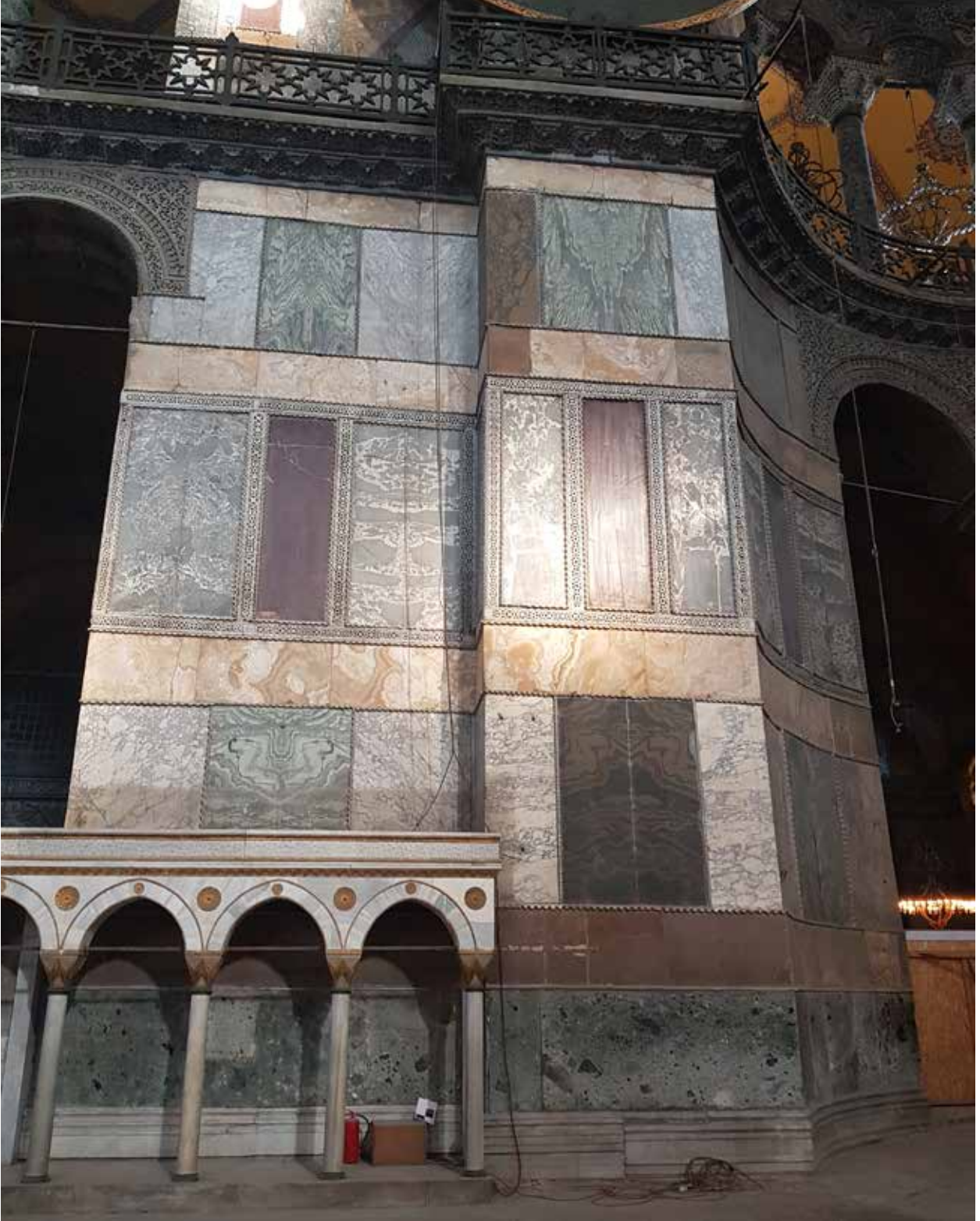
Resim 1: Ayasofya Kuzey İç Cephe Duvar Taş Kaplamalarından Görünüm
