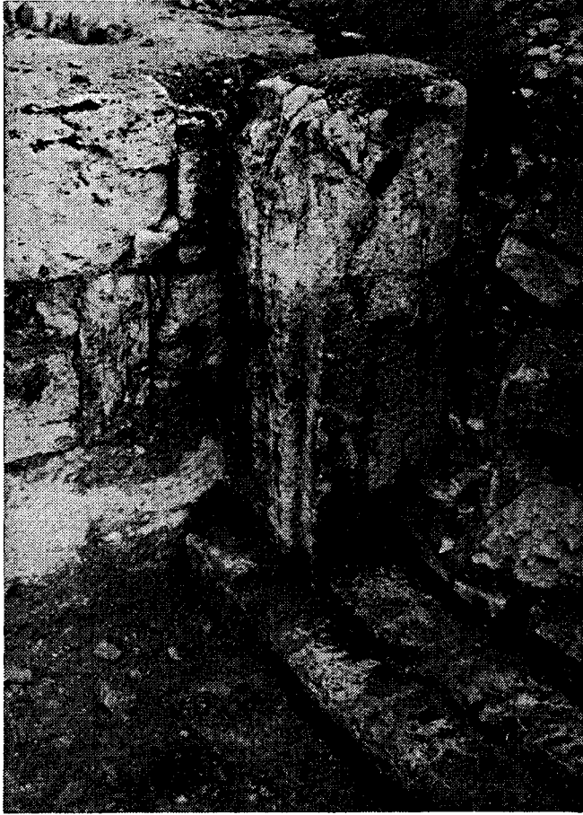
Res. 2 — Apsisin sağındaki ikinci niş
