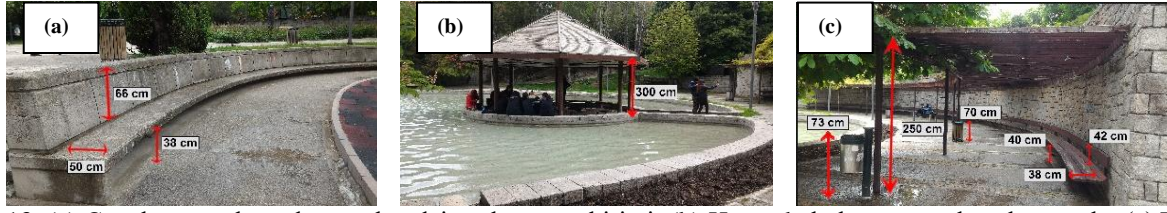
Şekil 13. (a) Çocuk oyun alanında yer alan dairesel oturma birimi; (b) Havuzda bulunan üstü kapalı pergola; (c) Havuz karşısında yer alan üstü açık dairesel pergola (Orijinal, 2017)
