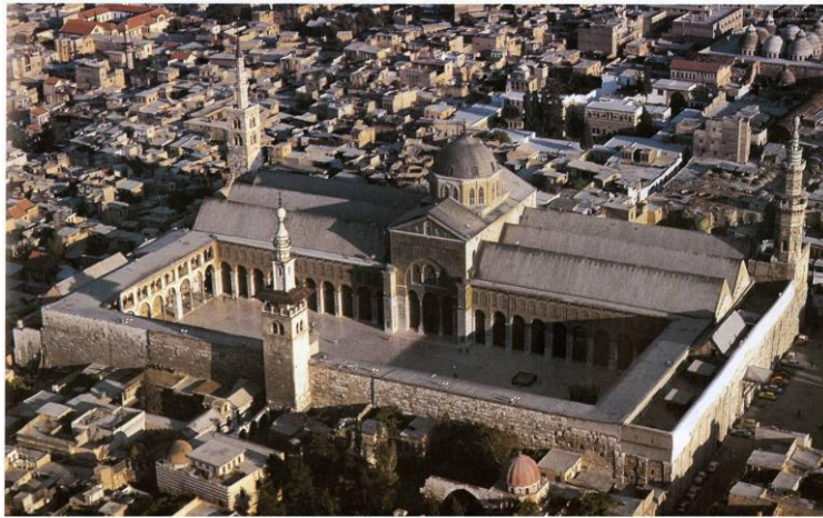
Foto. 4: Şam Emeviye Camii üstten görünüş (Friedman, 2015: 18).
