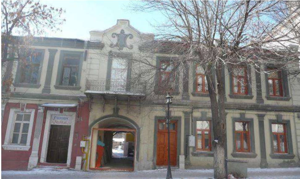
Şekil 42 Yapının zemin katının ticari işlevle kullanıldığı döneme ait bit fotoğraf (Türkan, 2017:166)
