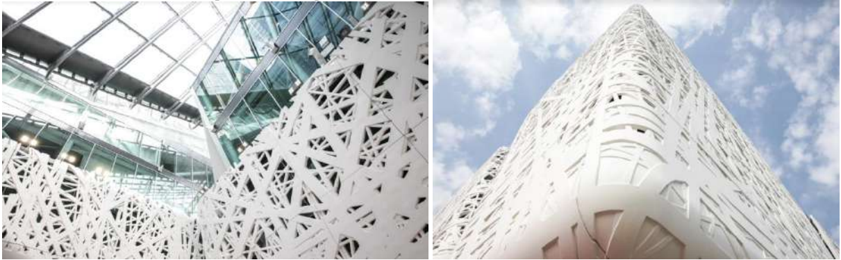
Şekil 11 ve Şekil 12. Biyodinamik betonun iç mekân ve dış cephe görünümü (URL – 5)
