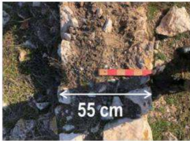
Şekil 13: Taş Temel Duvarı Genişliği. Didem Baran Ergül 2021
