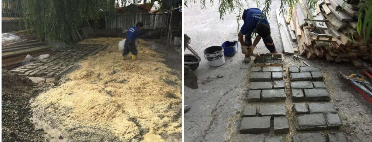
Şekil 3. Ayaş- Şeyh Muhittin Camii kerpiç hazırlanması
