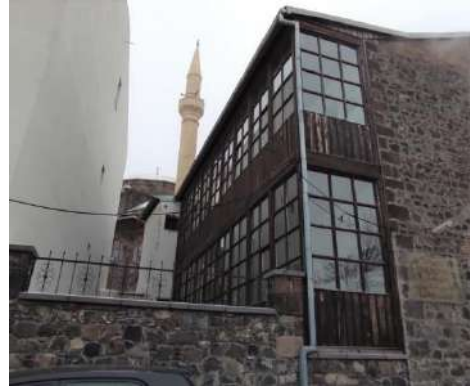
Şekil 25 Camekâna dönüştürülmüş veranda ve balkon, 2021 (yazarın arşivinden)
