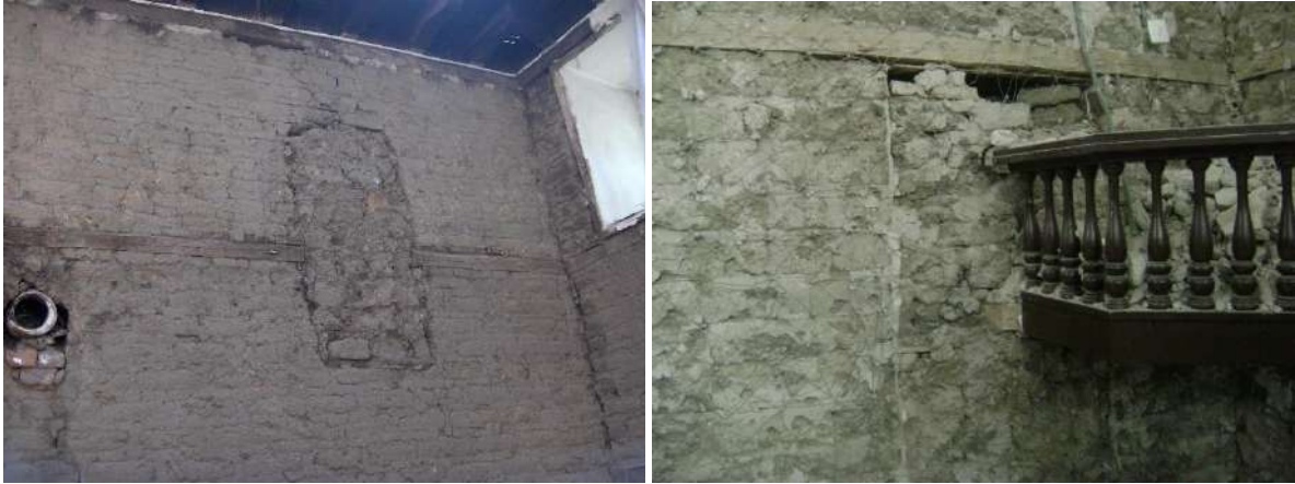
Şekil 8. Şeyh İzzettin Mescidi ve Hacettepe Camii kerpiç ve ahşap hatıl kullanımı
