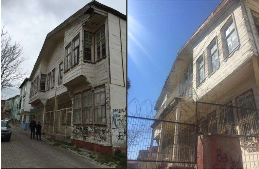
Resim 1 ve 2. Kuzey ve güney cephesinin Şubat 2019’daki görünümümü (Fot. Özlem Bozkurt arşivi )
