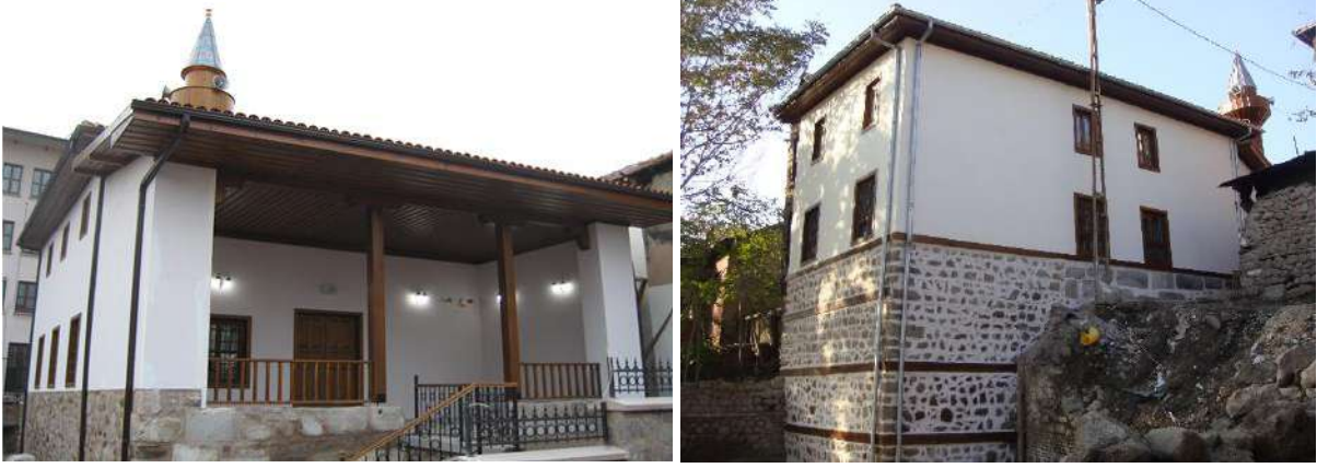
Şekil 6. Balaban Mescidi ve Şeyh İzzettin Mescidi subasman seviyesine kadar taş
