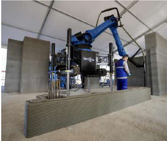
Şekil 15. Robotik Kol Yardımıyla Basım İşlemi (İSTON, 2021)
