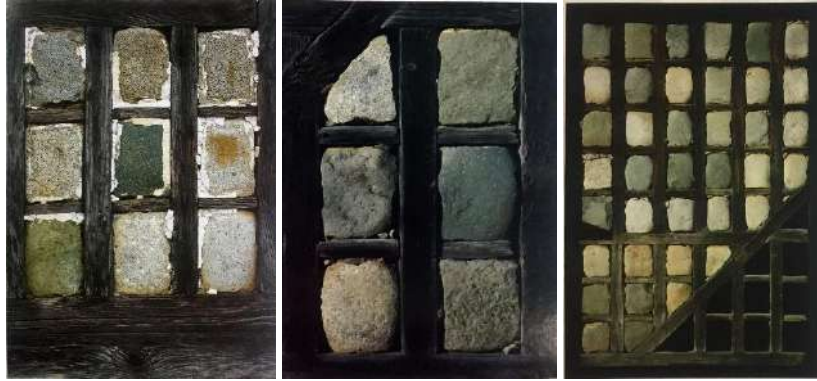
Şekil 10. Göz dolma sistem (Yıldırımkaya ve Sarıhan, 2008, s. 5-6)
