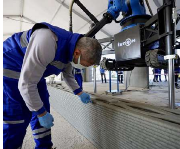
Şekil 16. 3D Betonun Basımı (İSTON, 2021)
