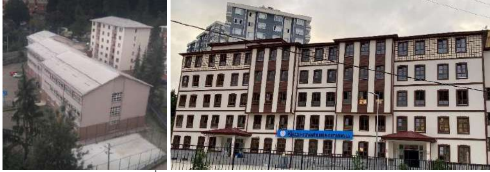
Şekil 24. Reşadiye Zihni Derin İlkokulu 2017 durumu (Google Maps) ve 2021 görünümü (Akar, 2021)
