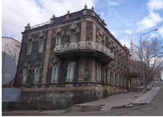
Şekil 21 Köşe parselde yer alan konut örneği, 2020 (yazarın arşivinden)
