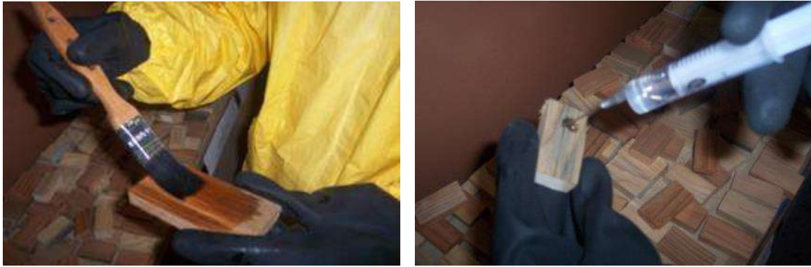
Şekil 1. Emprenye maddesinin uygulanması (a) Fırça ile (b) Enjeksiyon ile
