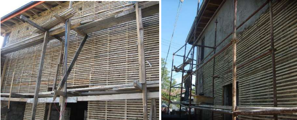
Şekil 13. Balaban Mescidi ve Kağncıoğlu Camii bağdadî uygulaması
