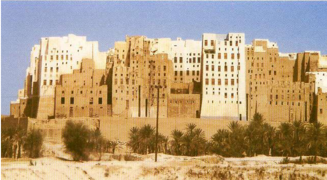
Şekil 1. Yemende çok katlı kerpiç yapı
