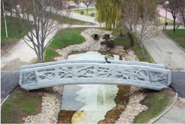
Şekil 10. 3D Yaya Köprüsü (IAAC, 2020)
