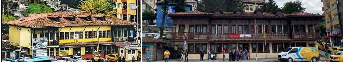
Şekil 22. Ptt - Rize Merkez Şubesi 2018 öncesi (Google Maps) ve günümüz durumu (Akar, 2021)
