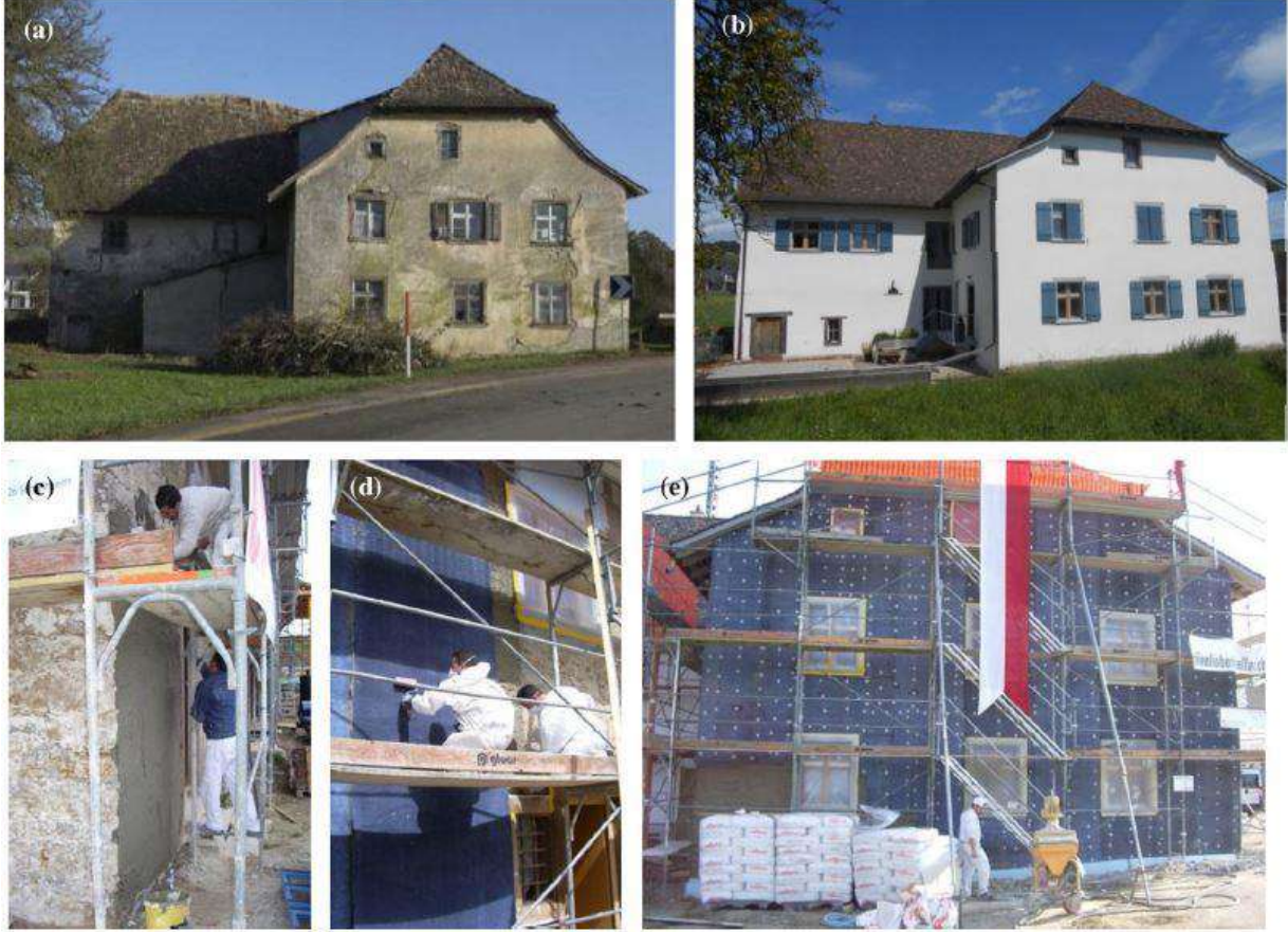
Şekil 9. İsviçre Hallau’da bulunan değirmen örneği, (a) yenileme öncesi, (b) yenileme sonrası, (c-f) cephede uygulama aşamaları. [12].
