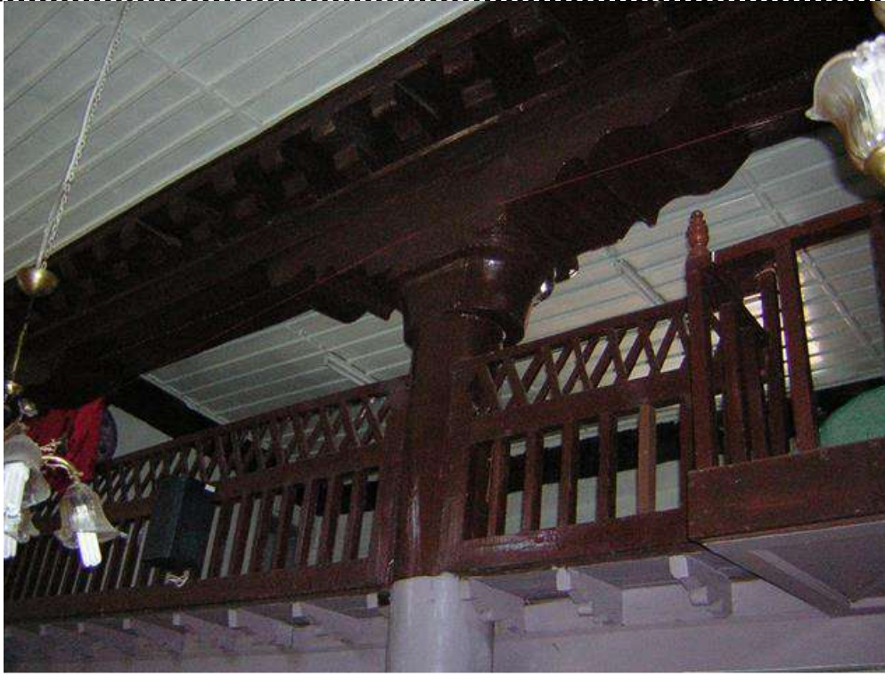
Şekil 9. Molla Büyük Camii harimdeki taşıyıcı sütun ve ahşap tavan
