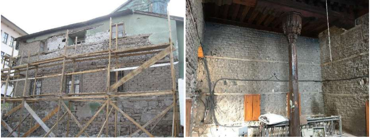
Şekil 7. Balaban Mescidi ve Geneği Mescidi kerpiç ve ahşap hatıl kullanımı
