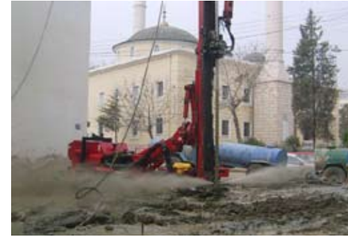
Şekil 4. Jet Grouting uygulama
